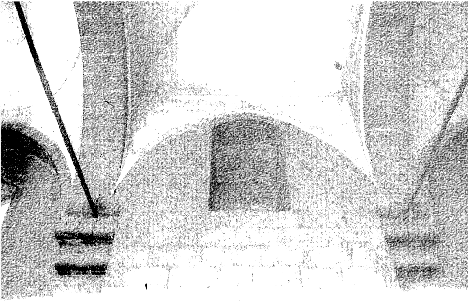
لوحة رقم ( ٦٨ ) الكواويل الساندة التي تحمل قبة مسجد الملكة صفية
